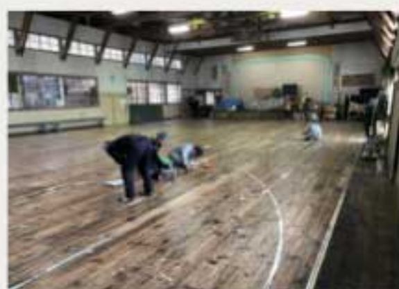
2025年3月。 在島メンバーとスタッフ、研修生も参加して、 研修所の稽古場の床を修繕しました。
