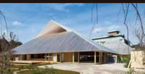
直島ホール 所有者：直島町 設計：三分一博志建築設計事務所
